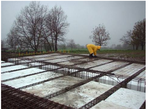
Foto estructura forjat sandwich.
